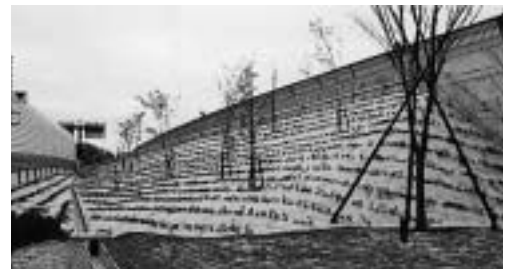
ハイテクマルチングパネル 施工時(ヘデラヘリックス5株/m) 東京外環自動車道、大泉IC
