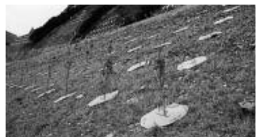
EPOマルチングボード、マーカーポール施工例
