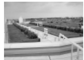
集合住宅屋上（共用部分）
